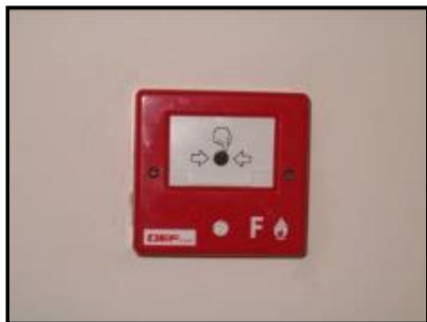
Pulsante di azionamento manuale allarme
