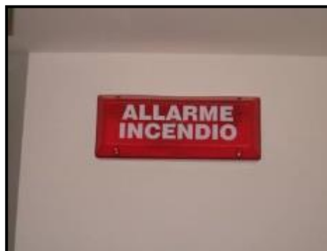
Pannello ottico acustico allarme antincendio
